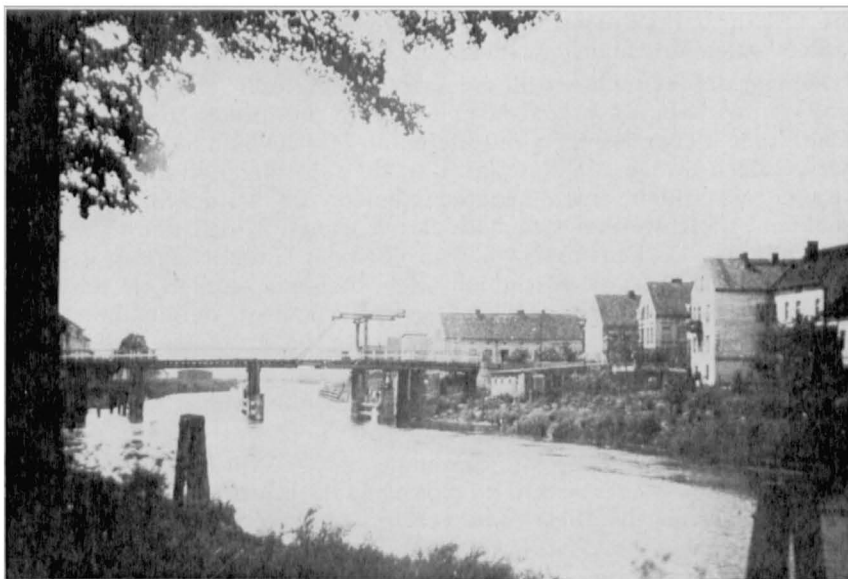
Die wiederhergestellte Klappbrücke über die Deime. Hier verlief der Verkehr vom Bahnhof zur Stadt
